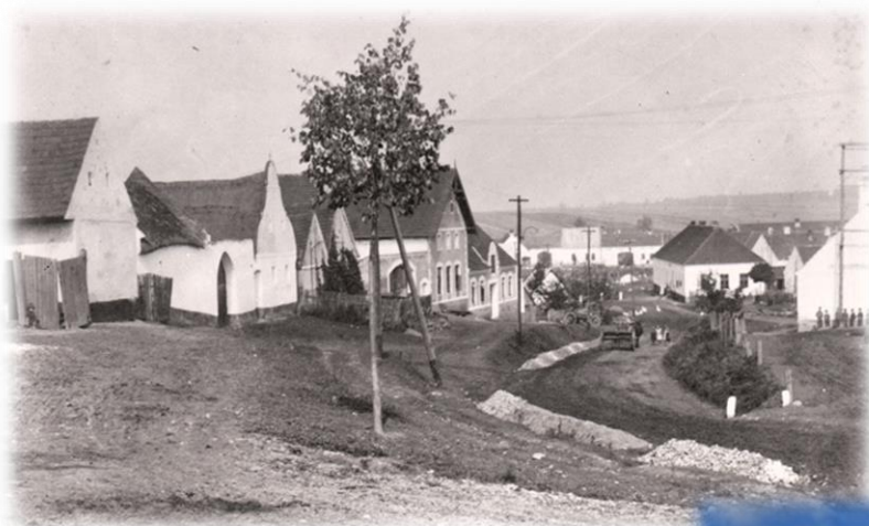
Výstavba nové silnice na návsi
